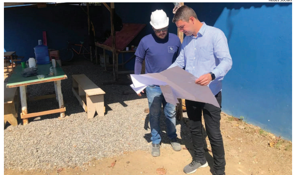
PREFEITO inspecionou o projeto da obra
