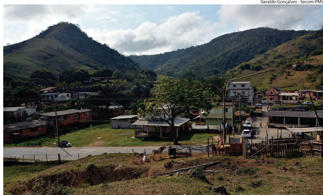
SERVIÇO incluiu a instalação dos hidrômetros
