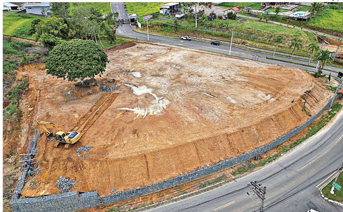
ÁREA DO TERRENO que acontece a terraplanagem para a construção do Hospital Municipal
