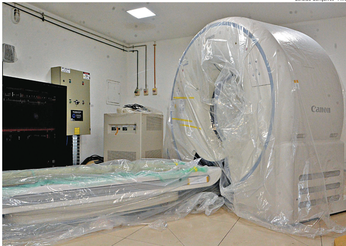
O NOVO tomógrafo está passando pelas últimas adequações
