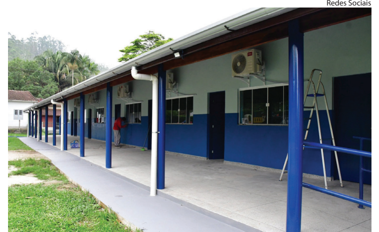
OBRAS DE MELHORIAS fazem parte das reivindicações dos moradores
