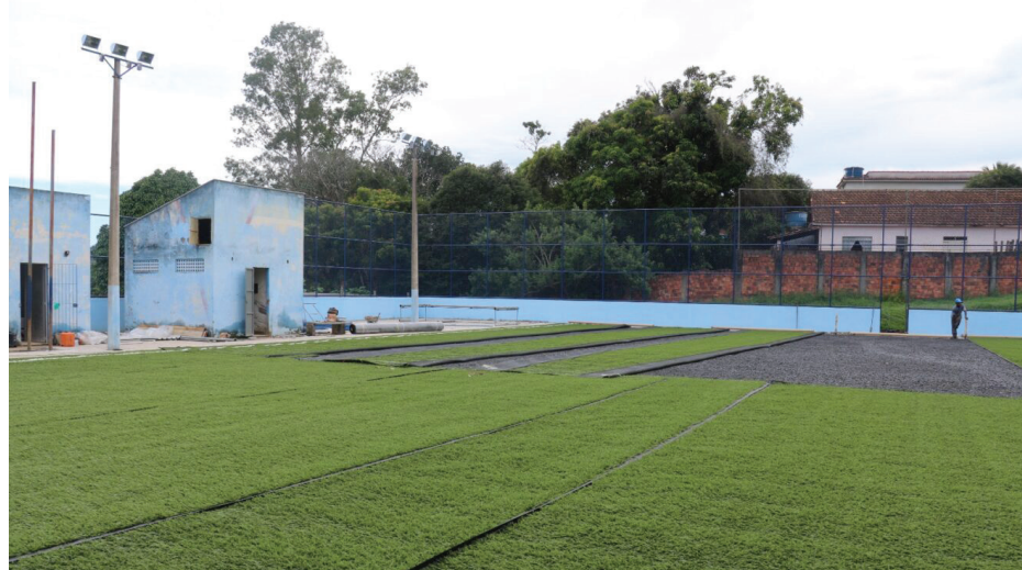
Campo de futebol está recebendo novo gramado, pintura de arquibancadas e troca de alambrado
