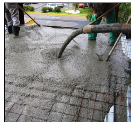
Lançamento de Concreto
