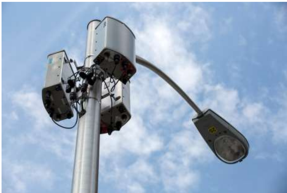
Small Cells instaladas na infraestrutura de IP
