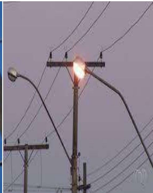
Exemplos de luminárias em falha: apagadas a noite, acessas de dia, luminosidade insuficiente.
