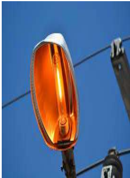
Exemplos de luminárias em falha: apagadas a noite, acessas de dia, luminosidade insuficiente.
