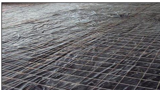
Lona plástica + Tela Metálica
