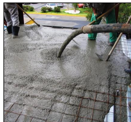
Lançamento de Concreto
