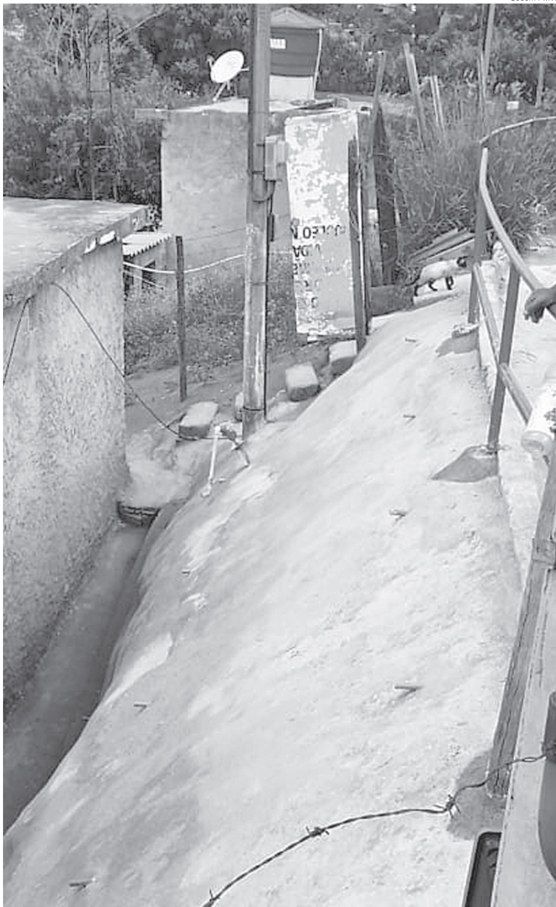
Furban executa obras com objetivo de minimizar transtornos causados pelas chuvas
