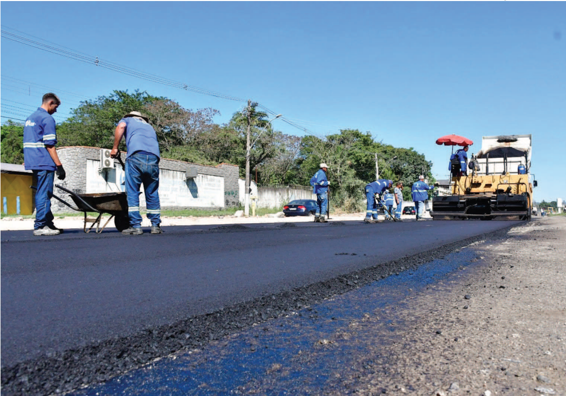
MAIS DE 750 TONELADAS de asfalto foram utilizadas em apenas dois dias de trabalho
