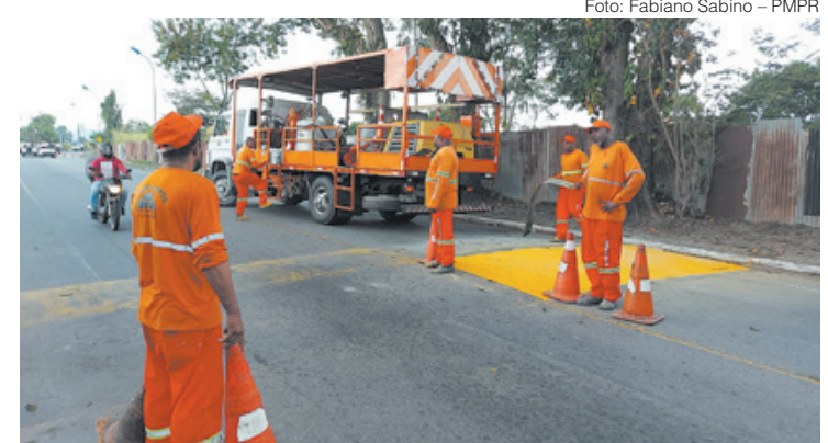
Trabalhadores da prefeitura melhoram sinalização de trânsito
