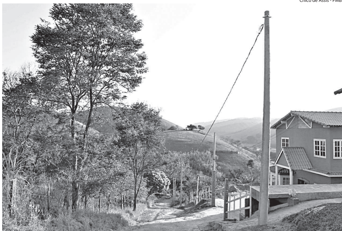
NOVOS POSTES estão sendo instalados no bairro
