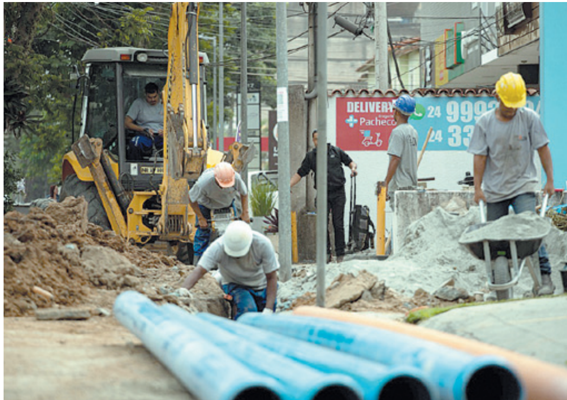
Serviços de troca de redes de água e esgoto são os primeiros a serem realizados no projeto de revitalização da via
