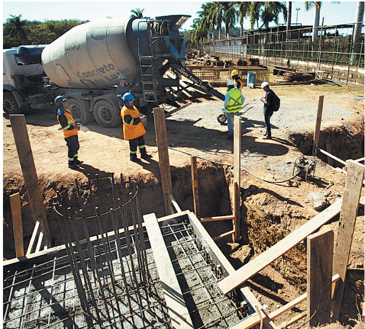
Trabalho para preenchimento dos blocos que vão sustentar os pilares da ponte teve início nesta segunda-feira. |
