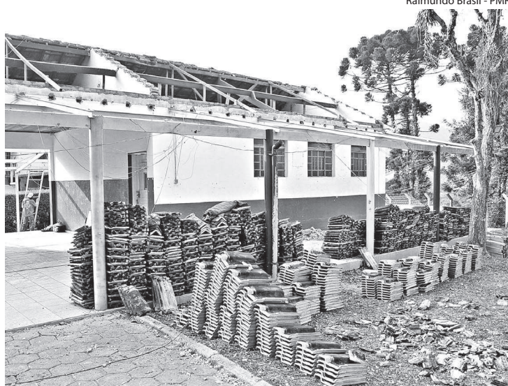
NOVO TELHADO da unidade já está sendo preparado
