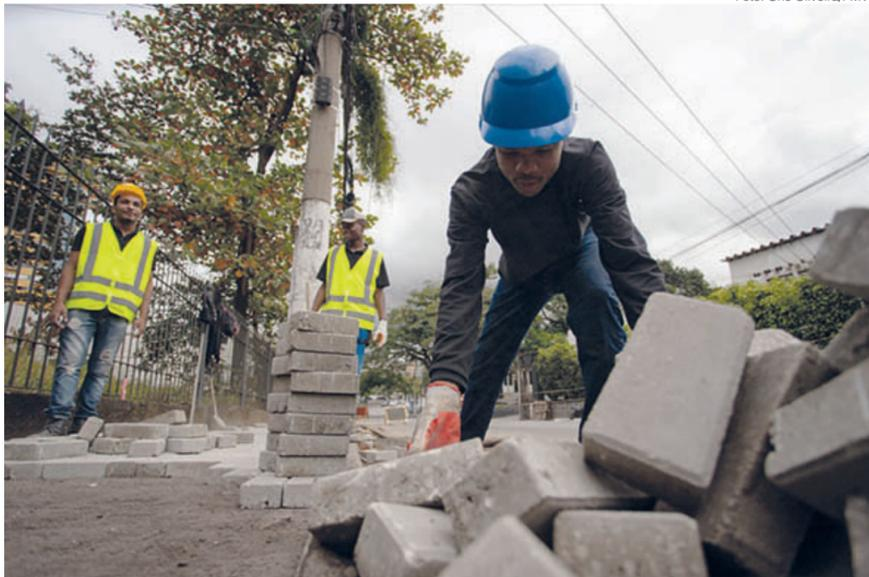
Calçadas contam com rampas e pisos táteis e intertravados, que possuem maior durabilidade e resistência
