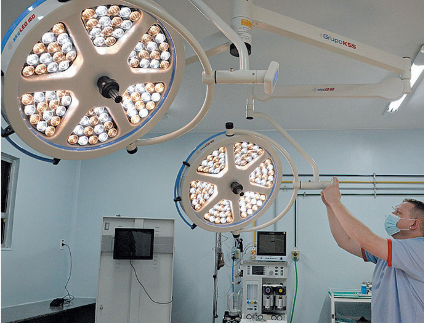
Focos cirúrgicos com lâmpadas de LED foram instalados na unidade médica e oferecem melhor visibilidade, além de promover economia energética
