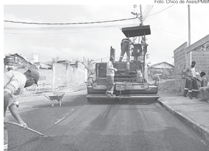
Desde que parceria com governo estadual foi firmada, cerca de 40 ruas já foram asfaltadas em Barra Mansa
