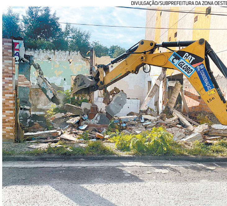
Construções começaram a ser derrubadas em Pedra de Guaratiba
