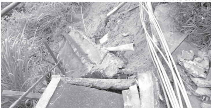
População deve evitar escavações e obras sem autorização para evitar acidentes
