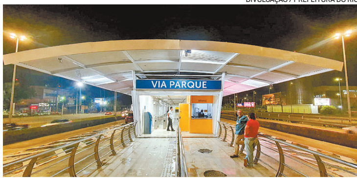
Estação de BRT Via Parque foi reformada pela Prefeitura do Rio
