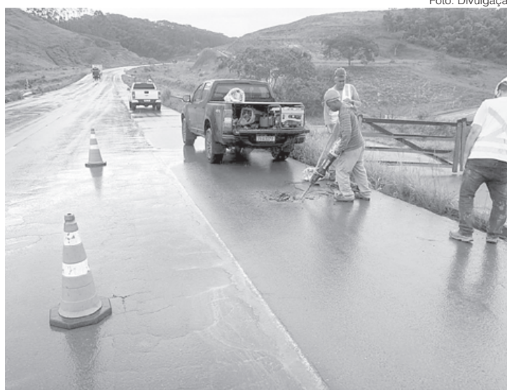
Empresa vai fazer avaliação da infraestrutura viária da Rodovia do Contorno
