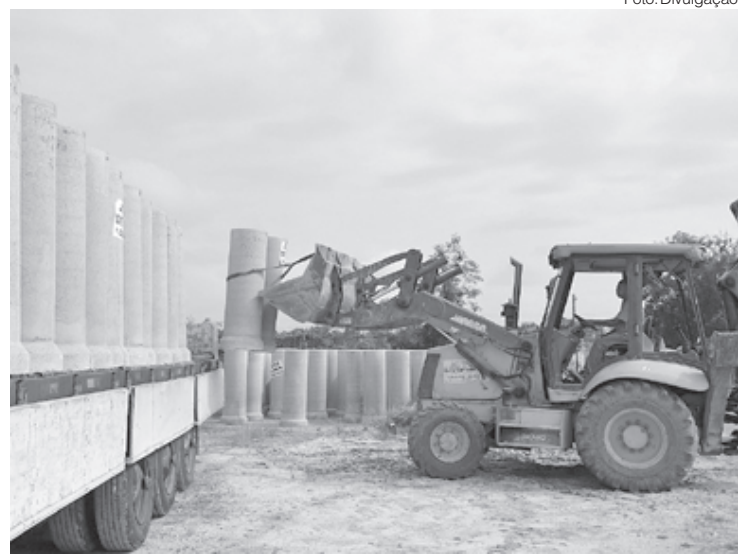
Unidades habitacionais estão sendo construídas no bairro Freitas Soares
