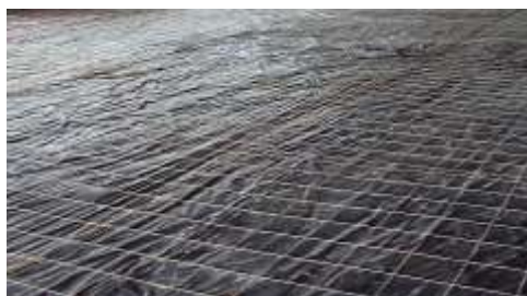
Colocação de lona plástica e tela metálica
