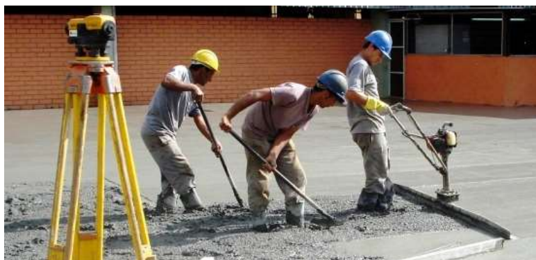
Nivelamento a laser
