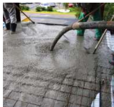
Lançamento de concreto
