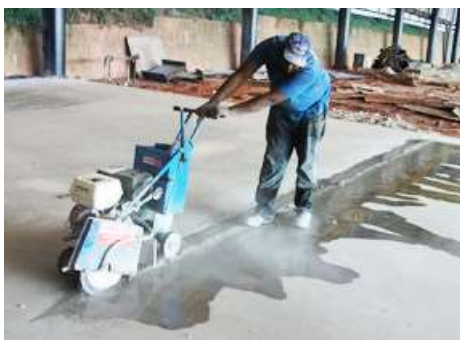
Corte mecânico de juntas
