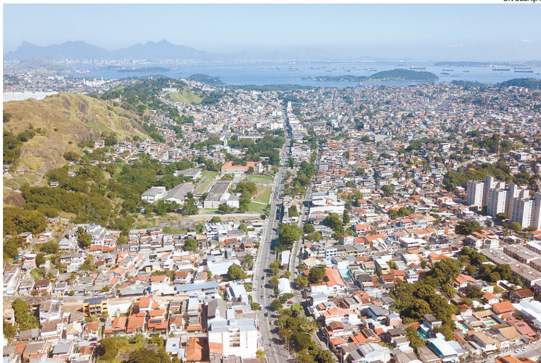
Os investimentos incluem, ainda, drenagem pluvial e obras de recuperação em conjuntos habitacionais
