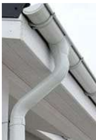
Imagem 13 – Calha e tubo de condutor.
