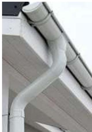
**Imagem 13** – Calha e tubo de condutor.
