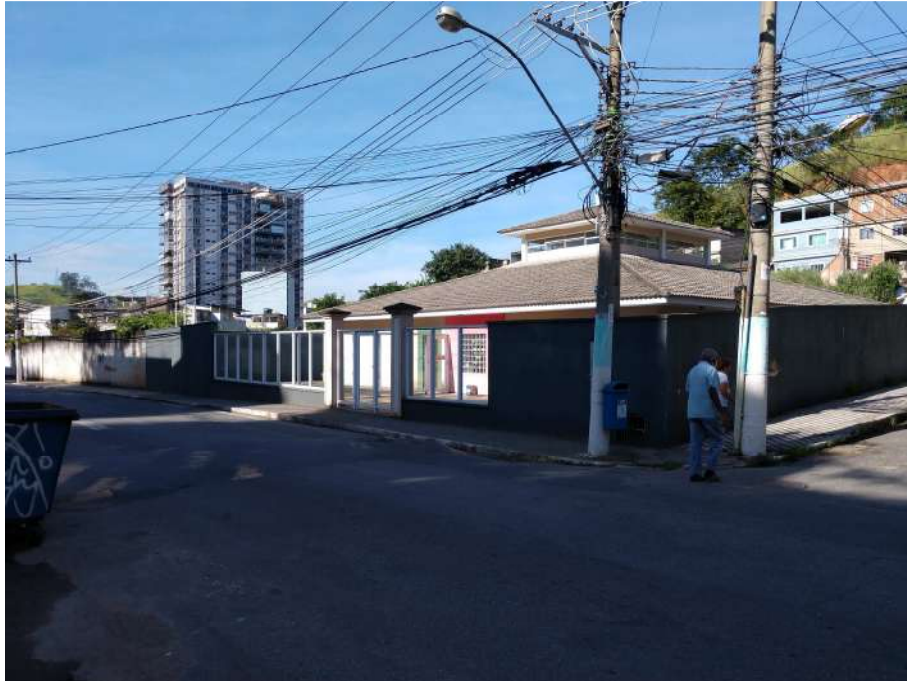
Foto 05- Divisa lateral direita. Detalhe esquina e vista parcial da Rua Antenor Rocha.
