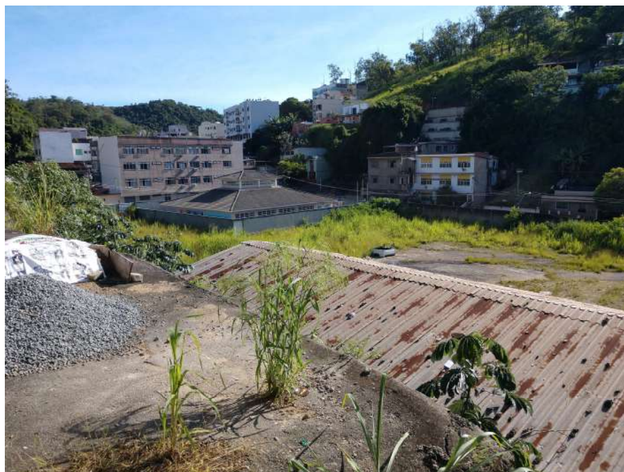
Foto 08- Fundos. Vista geral sentido Rua Antenor Rocha.
