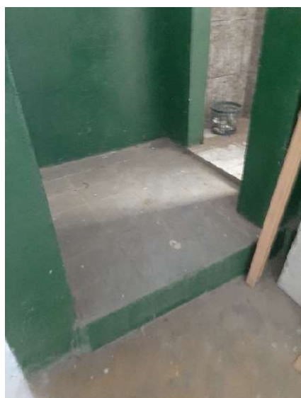
Foto 15: Desnível entre compartimentos
