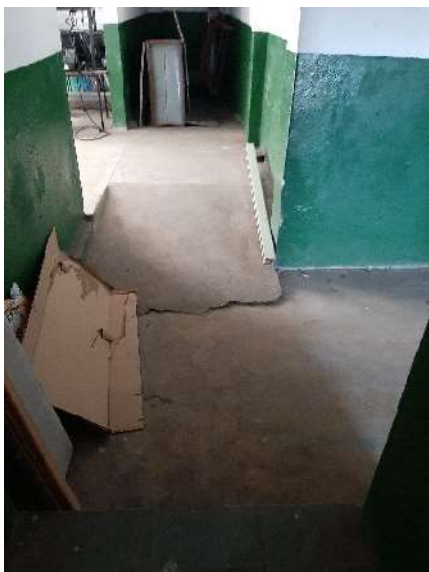
Foto 21: Desnível entre compartimentos
