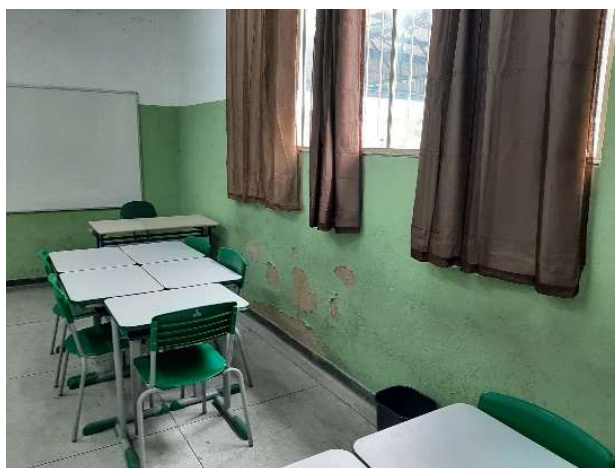
Foto 37: Infiltração na parede
