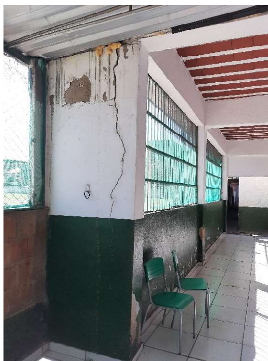
Foto 35: Rachadura em pilar com risco de sofrer colapso. Necessária reestruturação do pilar em caráter de urgência.
