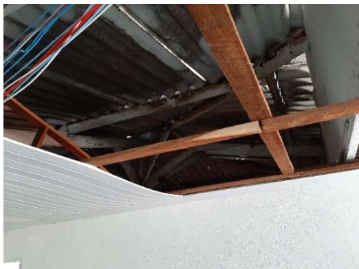
Foto 05: Fiação elétrica exposta junto à madeira e PVC
