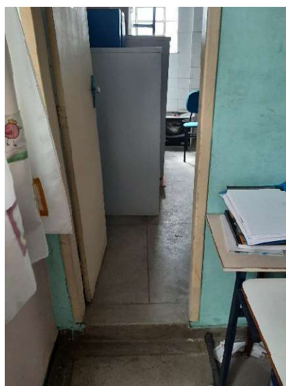
Foto 16: Desnível entre compartimentos
