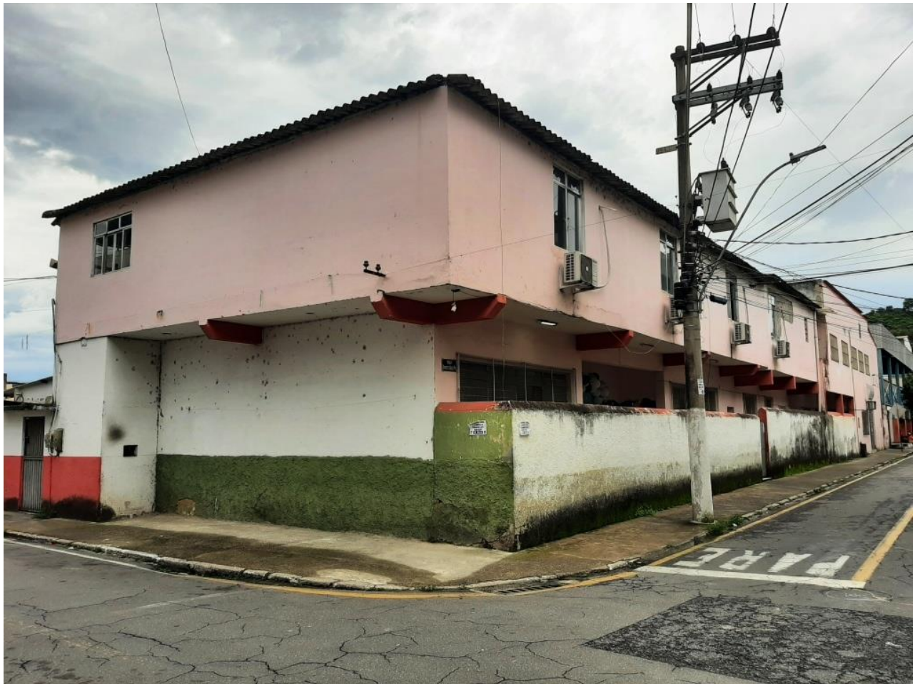
FACHADAS LATERAL E FRONTAL EXISTENTES (Rua Sete de Setembro, esquina com a Rua Demócrito Souza Pinto, nº. 80) Foto: Fevereiro 2023
