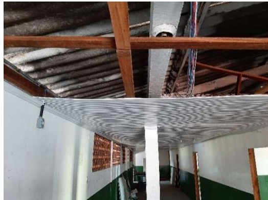
Foto 06: Forro de PVC empinado, fiação elétrica exposta
