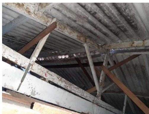
Foto 02: Tesouras com escoramentos precários
