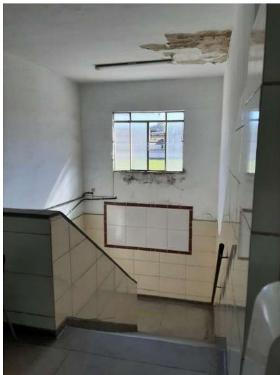
Foto 34: Escada de acesso ao 2º Pavimento. Infiltração na laje.
