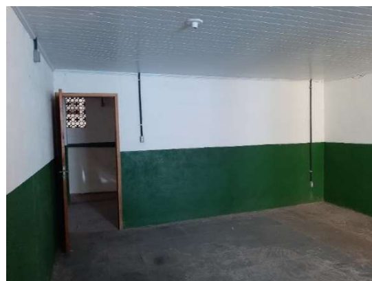
Fotos 43 e 44: Necessidade de execução de piso, troca de forro, esquadrias, pintura e colocação de cerâmica
