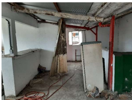
Foto 03: Estrutura precária da cobertura
