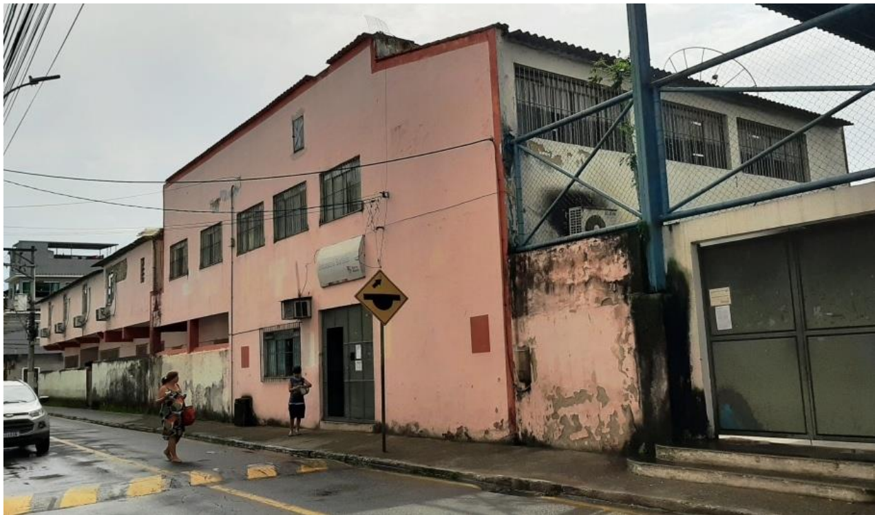
FACHADA FRONTAL EXISTENTE (Rua Demócrito Souza Pinto, nº. 80) Foto: Fevereiro 2023
