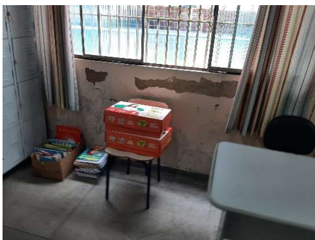
Foto 38: Infiltração na parede
