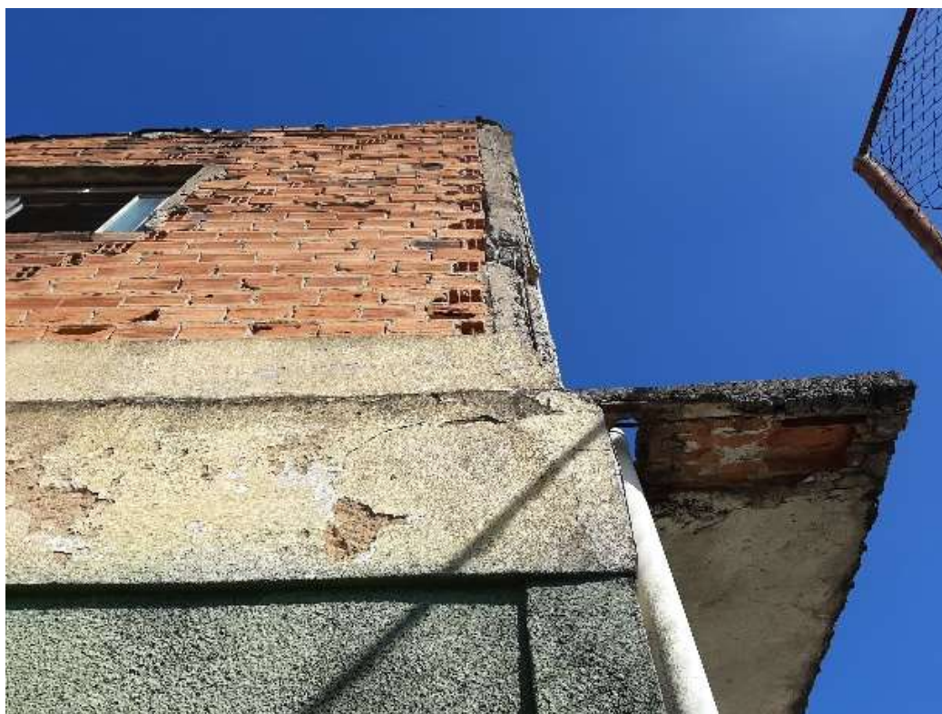
Foto 33: Estrutura precária com risco de sofrer colapso
