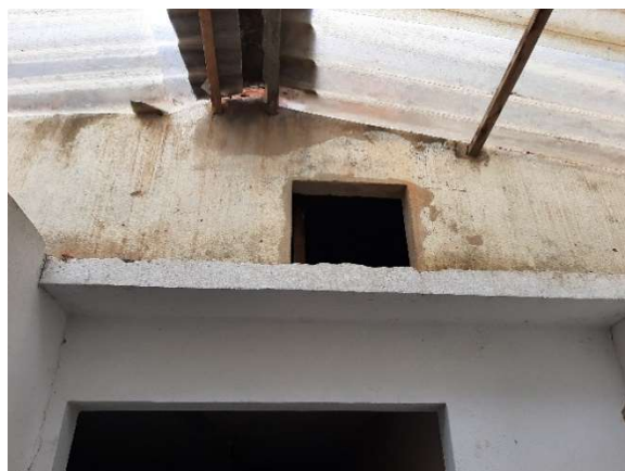
Foto 29: Telhado precário. Falta porta (alçapão)
