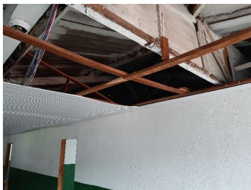
Foto 04: Forro de PVC empenado e faltando
