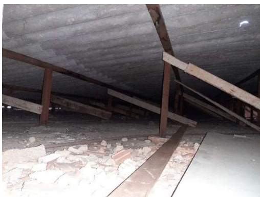
Foto 01: Telha quebrada e escoramentos precários
