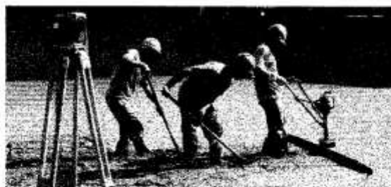
Nivelamento a laser
